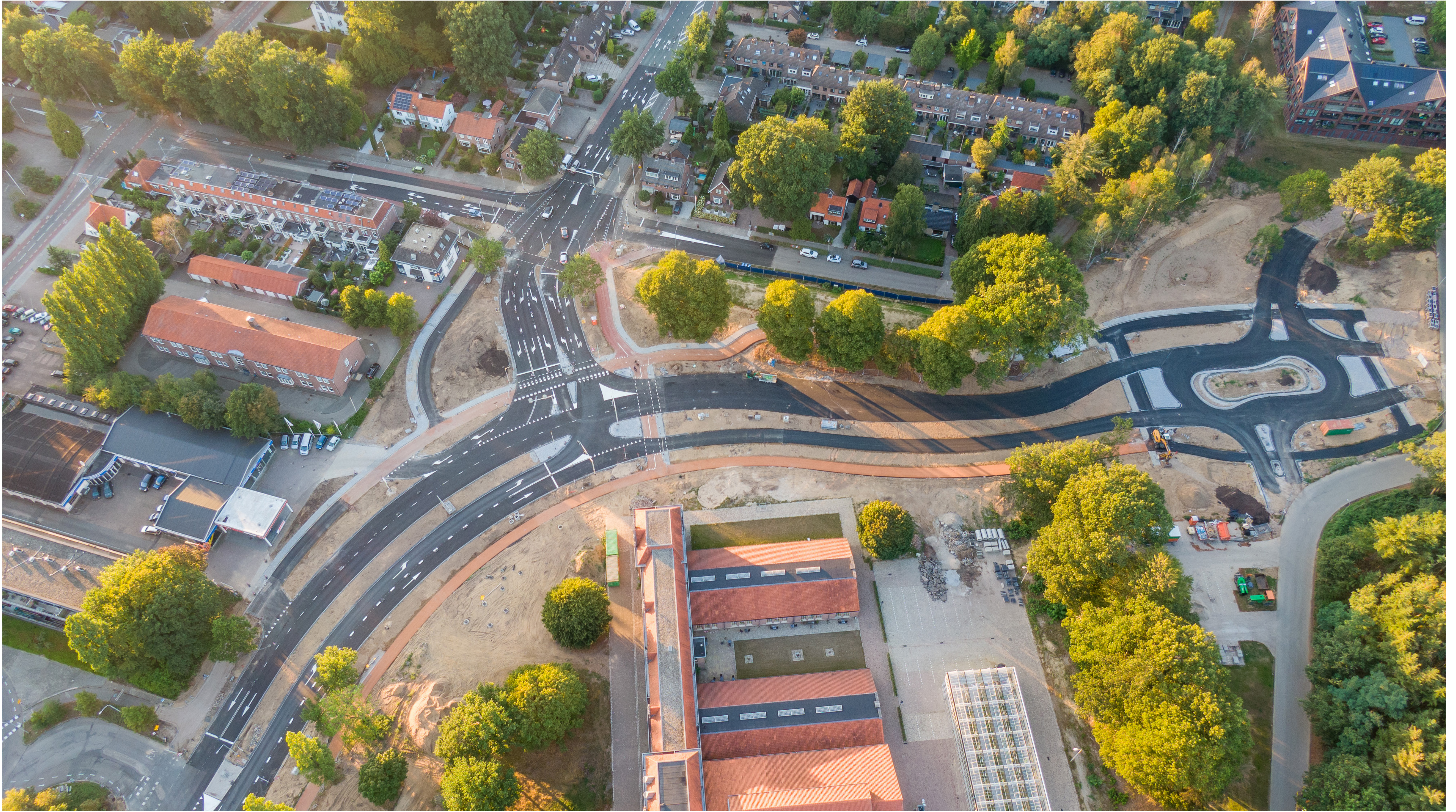
Foto gemaakt met een drone tijdens de aanleg van het kruispunt Klinkenbergerweg - World Food Center. Foto door RW Drones.
